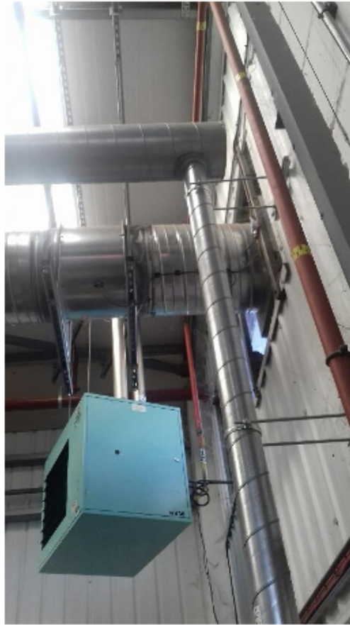
Fluids Plant – Axial inline fan
